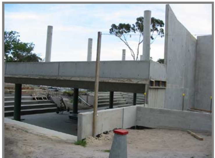
Hông bên phải, tầng dưới của chánh điện và tầng trên: chánh điện mới đang được dựng cột.
